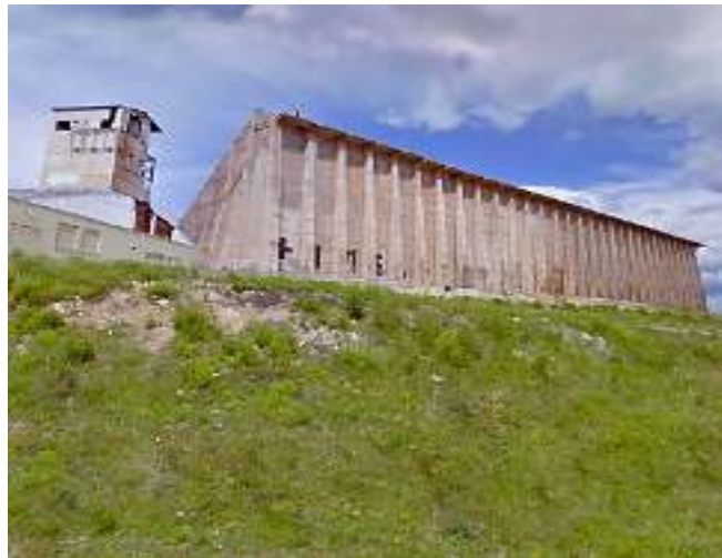
Antiguas instalaciones de la mina de Potasas de Subiza, en Beriáin
